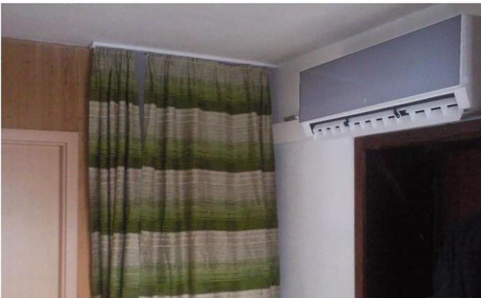
Die Verbindung zwischen den Komponenten wird mittels verkleideter Leitungen hergestellt, die eine nur 6.5 cm große Bohrung durch die Wand benötigen.
